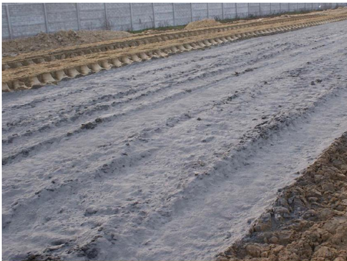
Фото. Будівництво окружної дороги в Мінську з використанням золи.
