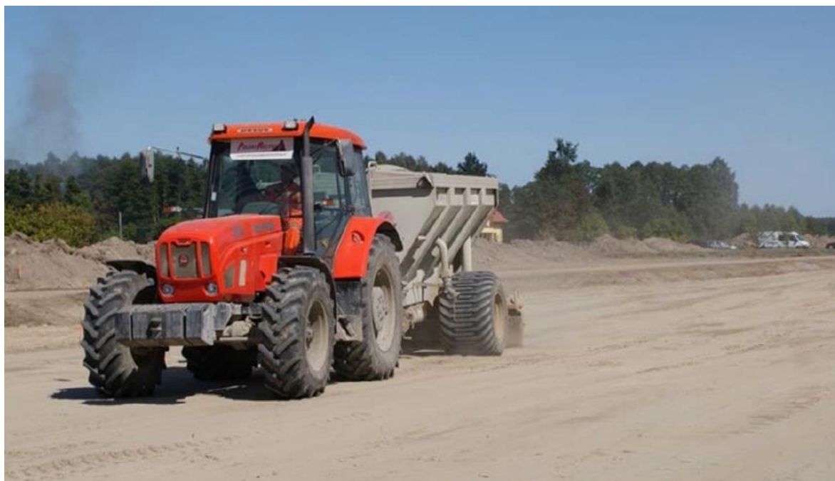
Фото. Будівництво окружної дороги в Мінську з використанням золи.
